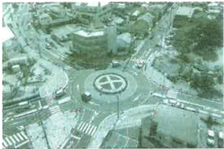
全国で初めて既存の信号機を撤去し導入したラウンドアバウト (長野県飯田市一写真提供:ラウンドアバウト普及促進協議会)
